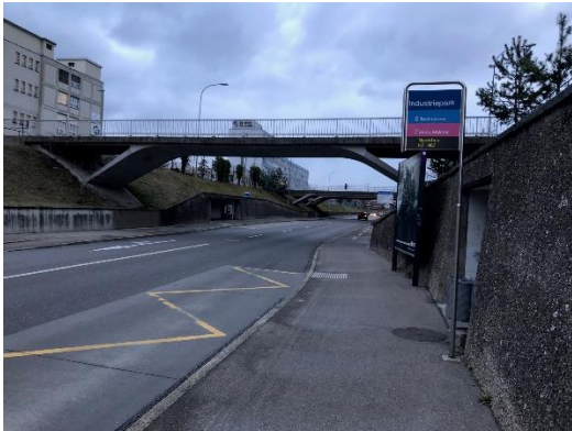
Ausgangslage bei Ankunft an der Busstation Industriepark (in Fahrtrichtung).
